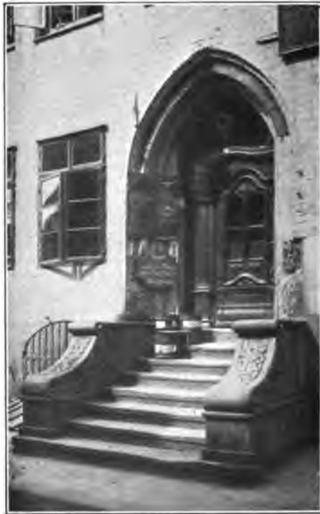
Aufgang zu einem Wohnhaus in Lüneburg
